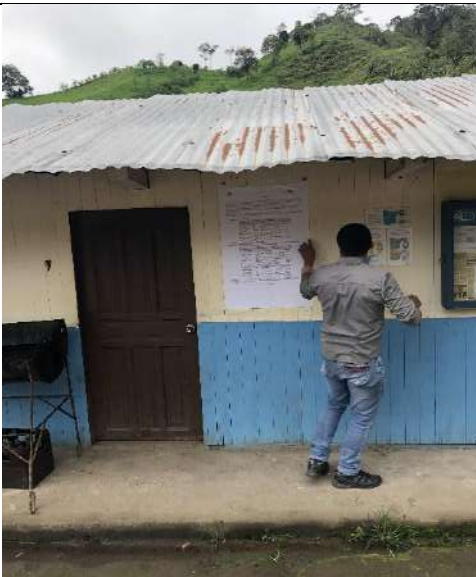
Foto 9: Comedor de la comunidad de Junín/28-12-2018.
