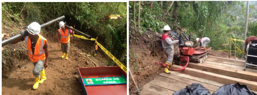
Fotografías Nro. 22 y 23. Transporte de tubería y nivelación de plataforma de perforación
