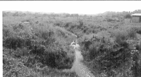
Fotografía 10: Adeuación de canales de desagüe.
