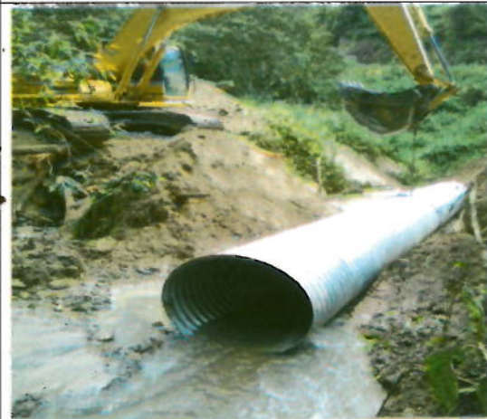
COLOCACION DE ALCANTARILLA
