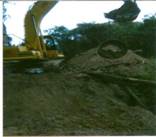
COLOCACION DE ALCANTARILLA
