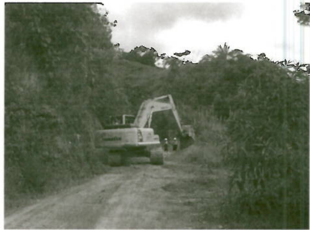
Trabajos de mantenimiento vial, maquinaria ENAMI EP
