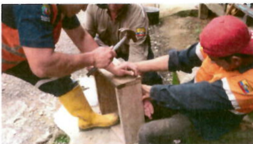
Preparación de molde
