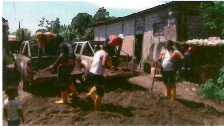
Trabo de relleno de via en el sitio el Cuerval
