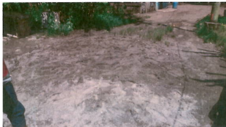
Vista final de la via rellena
