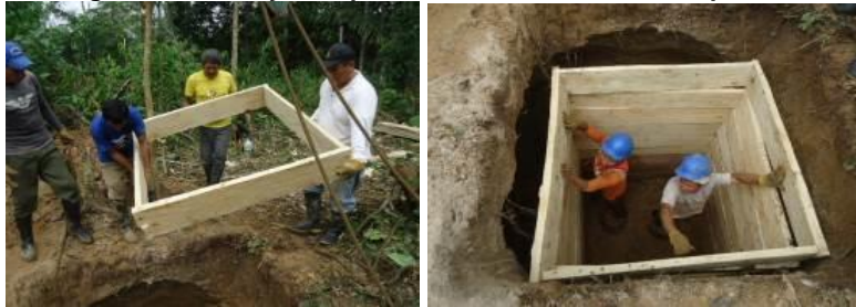
Fotografías Nro. 36 y 37. Apertura de Pozos Manuales Exploratorios
