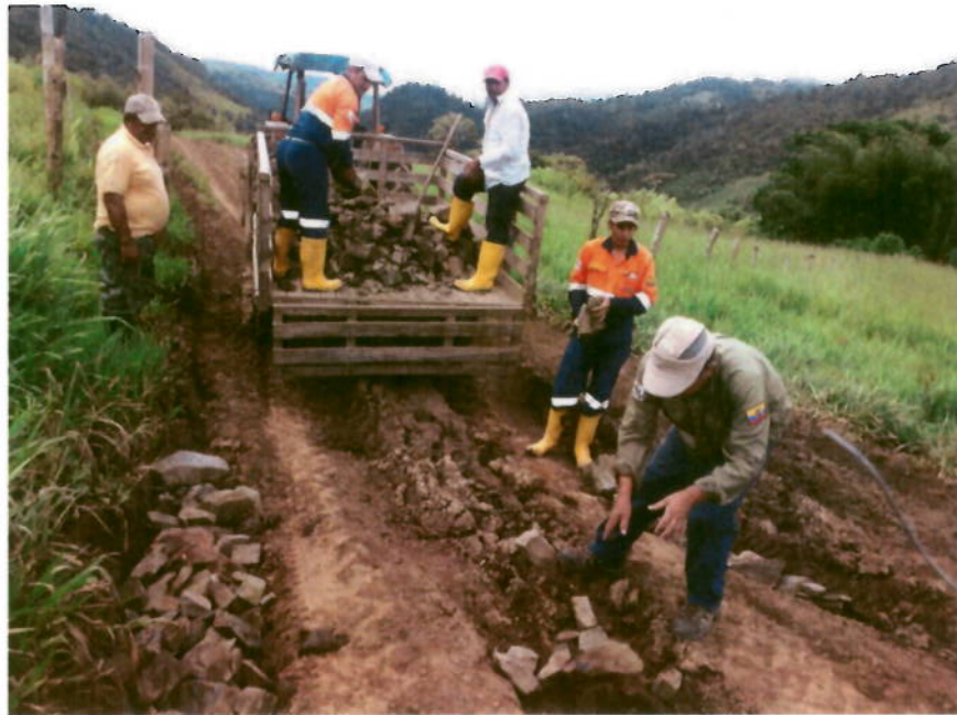
Fotografía # 3 Minga para mejoramiento de vía
