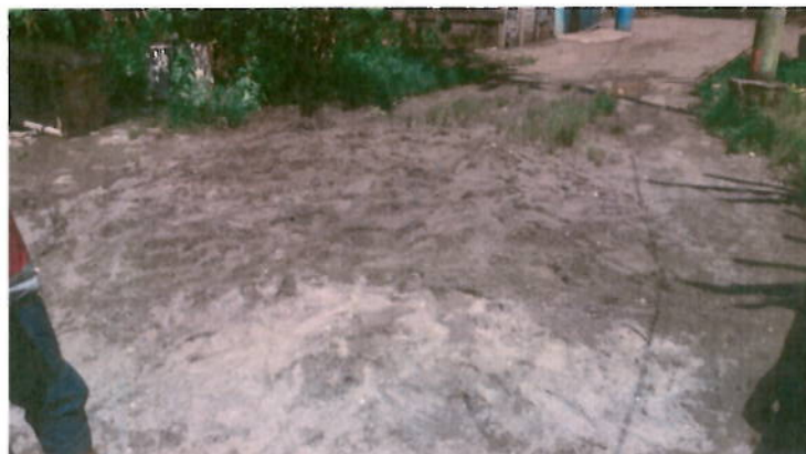
Vista final de la via rellena
