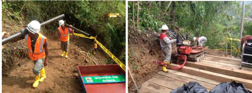
Fotografías Nro. 22 y 23. Transporte de tubería y nivelación de plataforma de perforación
