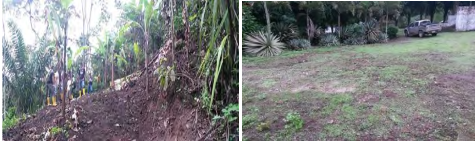
Fotografías Nro. 24 y 25. Rehabilitación de las plataforma de perforación TOR01 y TOR02
